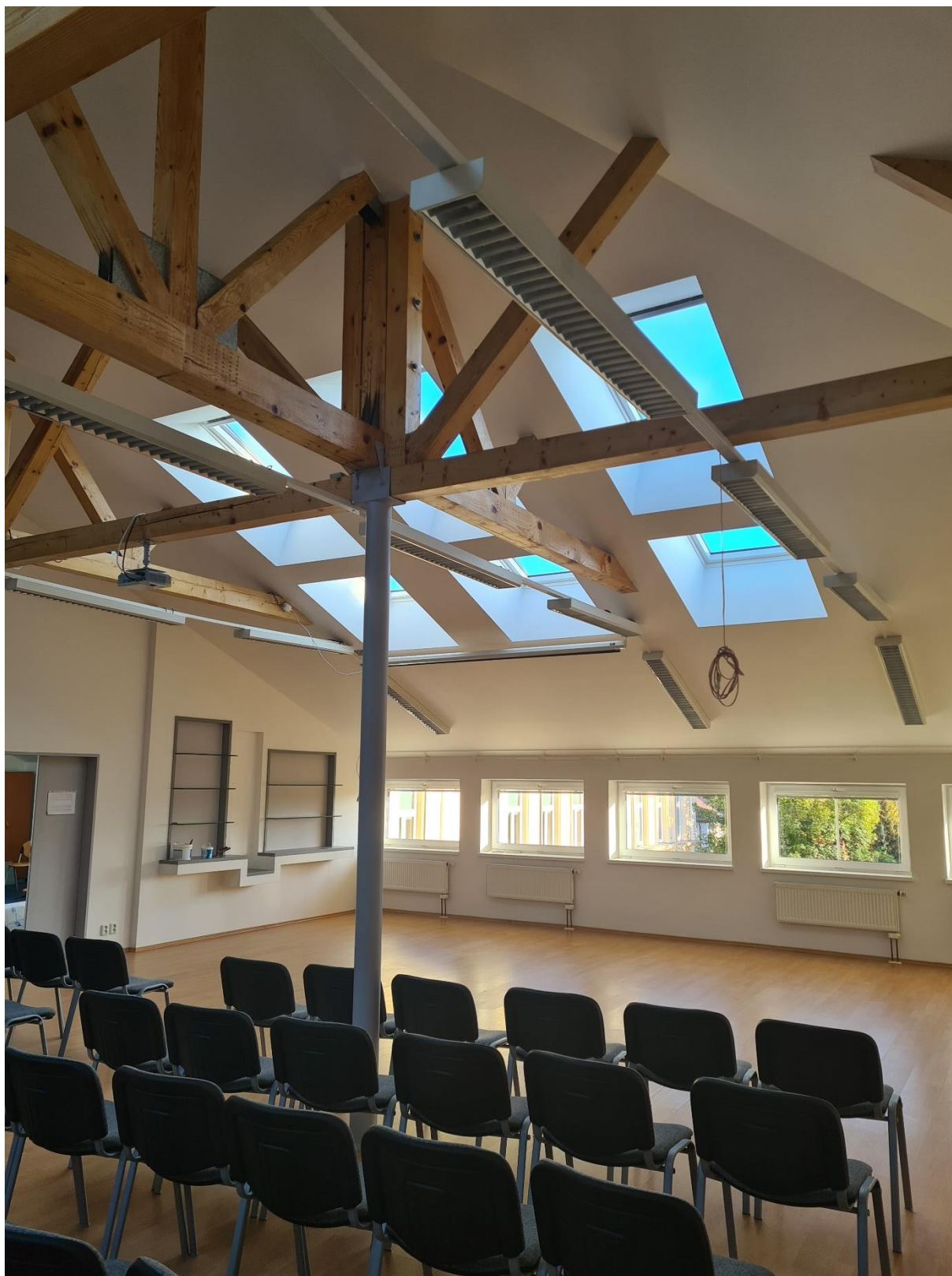
Obrázek 20: Nová střešní okna (pohled z auly)
