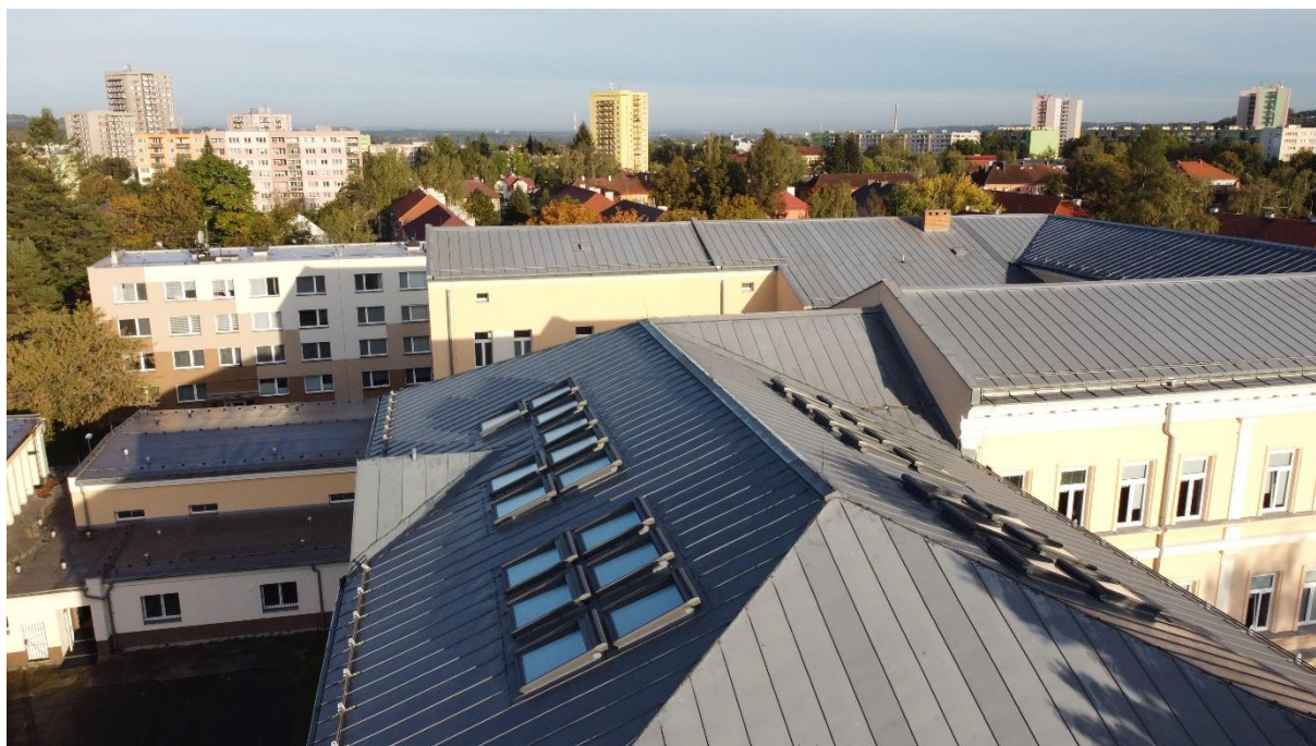
Obrázek 19: Nová střešní okna (pohled z venku)
