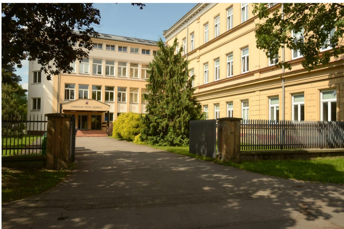
Obrázek 10: Budova školy po a před rekonstrukcí
